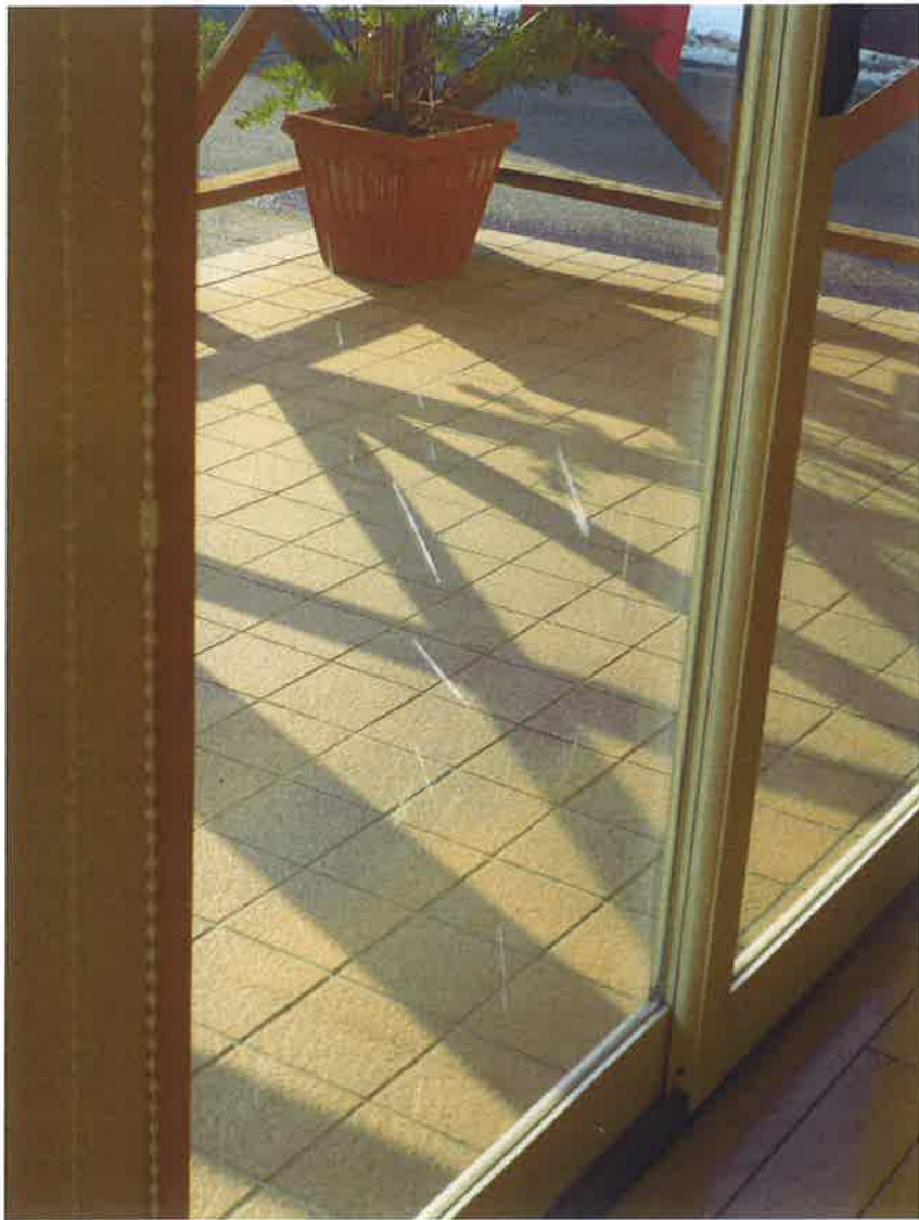
スクレーパー削りによるガラスの擦り傷
